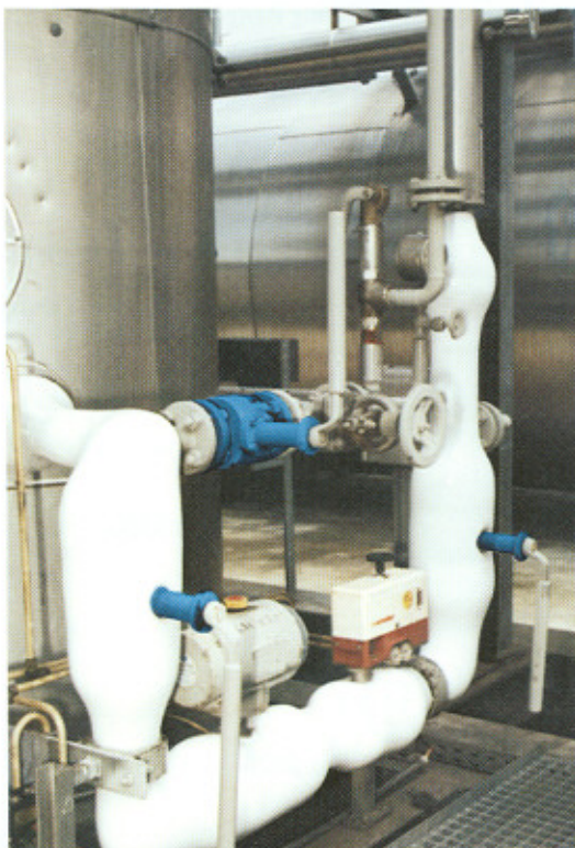
Kugelhähne für Tieftemperatureinsatz Ball Valves for Low Temperature Service
